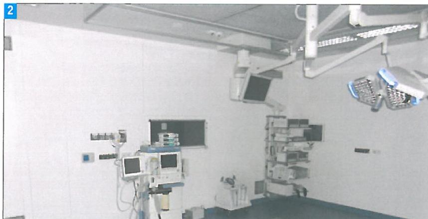
2. VISTA PARZIALE DI UNA DELLE NUOVE SALE OPERATORIE DI CATEGORIA ISO 5 DOTATA DI UN SOFFITTO FILTRANTE CON FILTRI ASSOLUTI DI EFFICIENZA H14.
