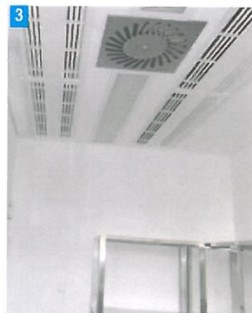
3. UN PARTICOLARE DEL SISTEMA DI DIFFUSIONE DELL'ARIA NEL REPARTO DI STERILIZZAZIONE CON DIFFUSORI ELICOIDALE DOTATI DI FILTRI H14 - E A SINISTRA DIFFUSORI DEI CONVETTORI TIPO VENTAGLIO.
