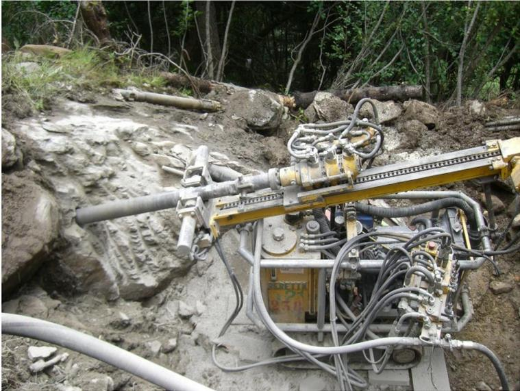
**Ankerbohrung am linken Widerlager**
