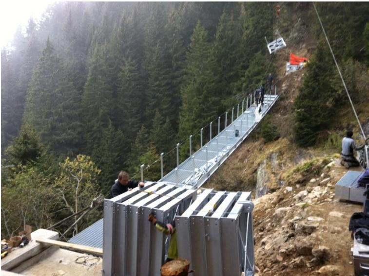
**Einfahren und Montage der vorgefertigten Brückenteile**
